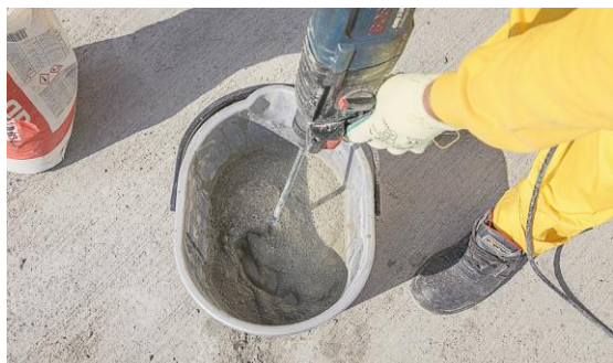
Fig. 5 Prepararea și aplicarea mortarului adeziv tip CELCO pe plăcile IZOMINERAL
