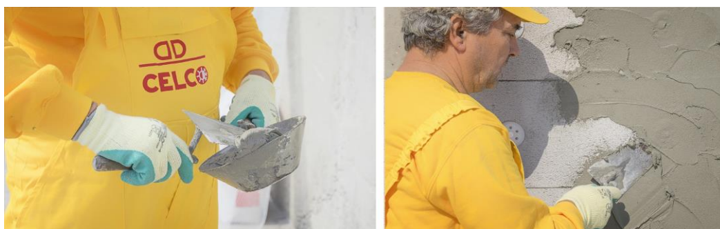
Fig. 8 Aplicarea plasei din fibră de sticlă și înglobarea ei în stratul de masă de șpacu tip CELCO
