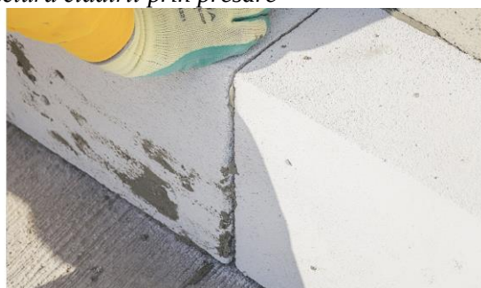
Fig. 6 Aplicarea plăcilor IZOMINERAL pe structura clădirii prin presare
