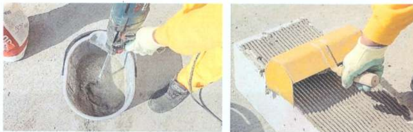
Fig. 5 Prepararea și aplicarea mortarului adeziv tip CELCO pe plăcile IZOMINERAL
