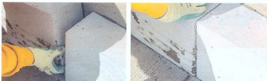
Fig. 5 Prepararea și aplicarea mortarului adeziv tip CELCO pe plăcile IZOMINERAL
