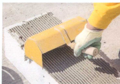
Fig. 5 Prepararea și aplicarea mortarului adeziv tip CELCO pe plăcile IZOMINERAL
