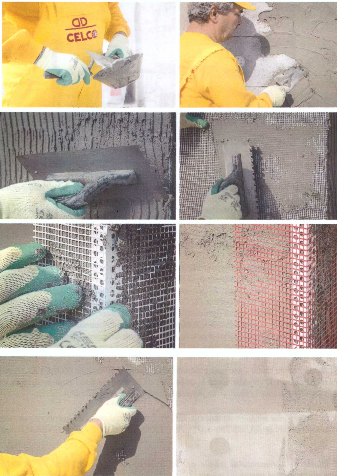
Fig. 8 Aplicarea plasei din fibra de sticlă și înglobarea ei în stratul de masă de șpaclu tip CELCO
