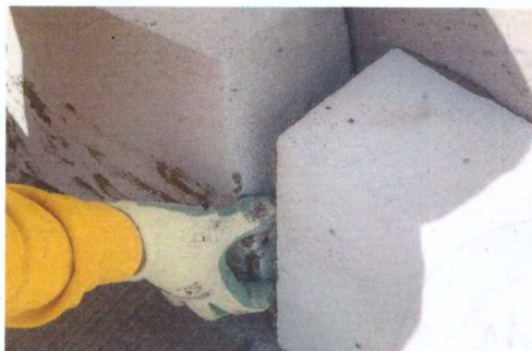
Fig. 6 Aplicarea plăcilor IZOMINERAL pe structura clădirii prin presare
